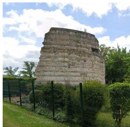
Quelques vestiges sont encore visibles
