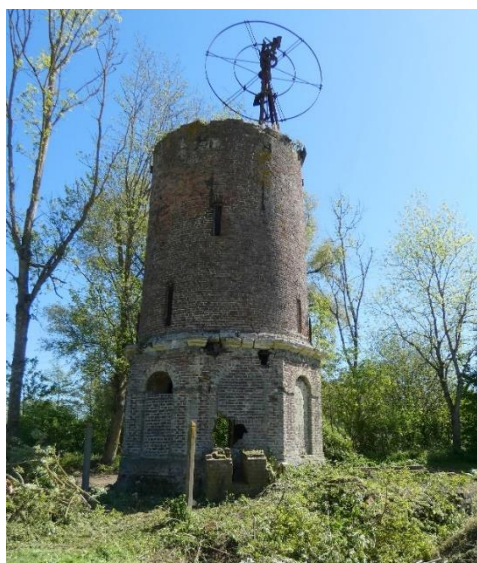
Après nettoyage, mai 2016, photo J. Pavy
